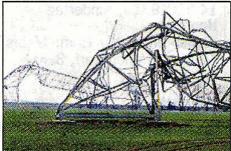
Nach dem Orkan: geknickte Strommasten
