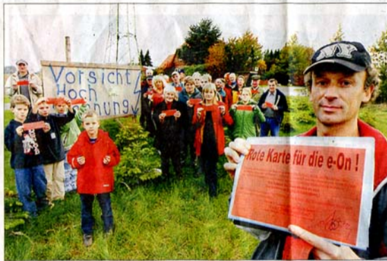
Mit roten Karten für Eon drücken die Anwohner um Gerd von Seggern (vorne) ihren Protest gegen die Überlandleitung aus. Im Hintergrund ein Strommast der bestehenden 110-Kilovolt-Leitung neben einem Haus. BILD: KONKEL
