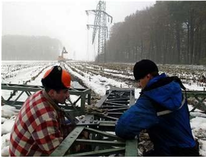
RWE-Monteure schrauben bei Ochtrup einen Notstrommast zusammen Foto: DPA
